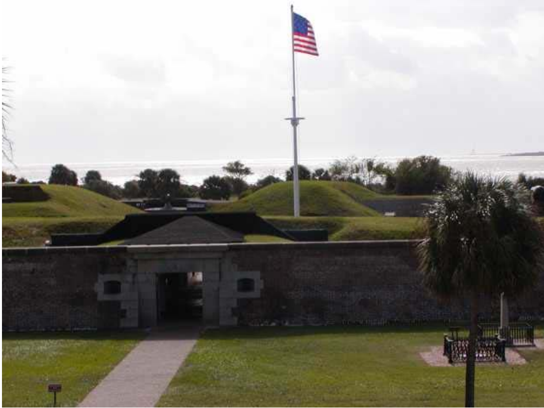
Fort Moultrie – Sullivan’s Island, SC (NRHP)
